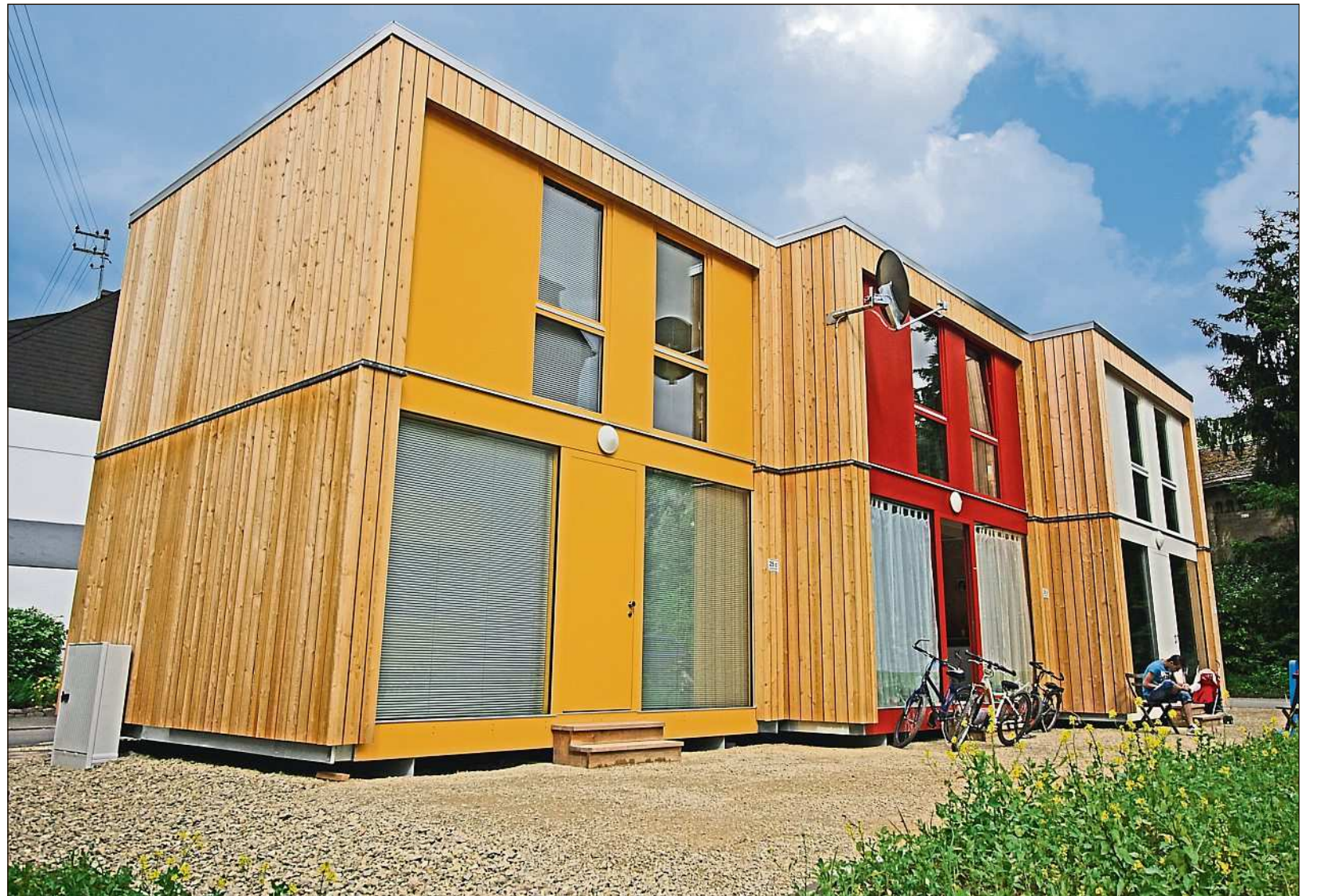
Sehr flexibel – die Modulbauweise eignet sich für die Schaffung von Wohnraum für Flüchtlinge.
